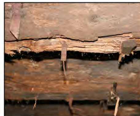
État des poutres de soutènement
