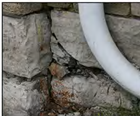
État des fondations
